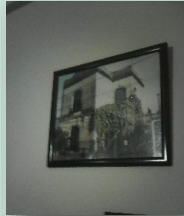
Casa de calle Pasaje González
